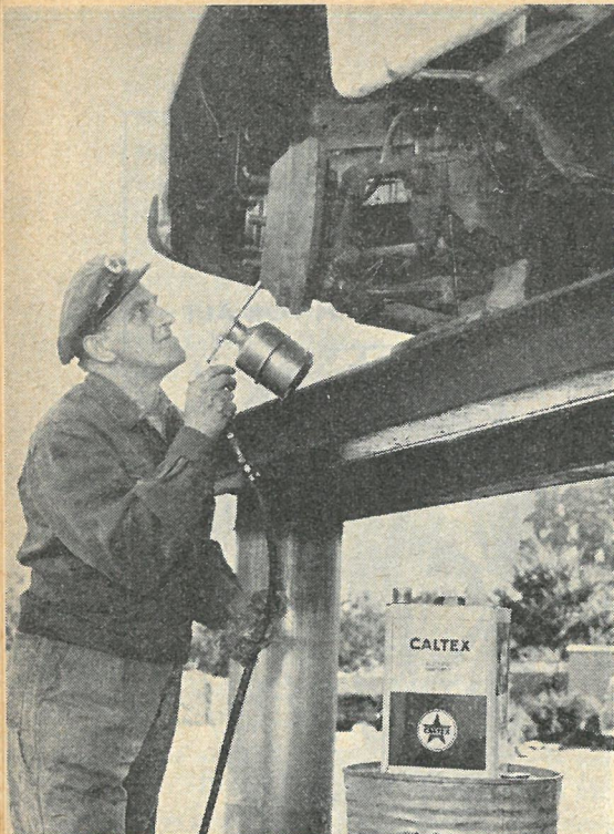
Det rustbeskyttende olieprodukt sprøjtes på undervognen, og det finder på den måde ind alle vogne.
