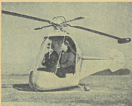
Amerikansk, 2-personers Hiller HJ-2 Hornet helikopter, hvis eneste drivkraft er to ramjet-aggregater, der hver for sig er anbragt i spidsen af en af de to bærende rotorvinger.
