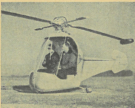
Amerikansk, 2-personers Hiller HJ-2 Hornet helikopter, hvis eneste drivkraft er to ramjet-aggregater, der hver for sig er anbragt i spidsen af en af de bærende rotorvinger.
