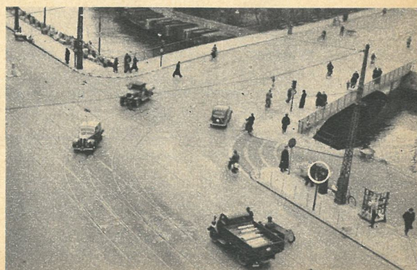
Pilen ved Børsbroen er sammenbygget med Trafiksignalet. ↓
