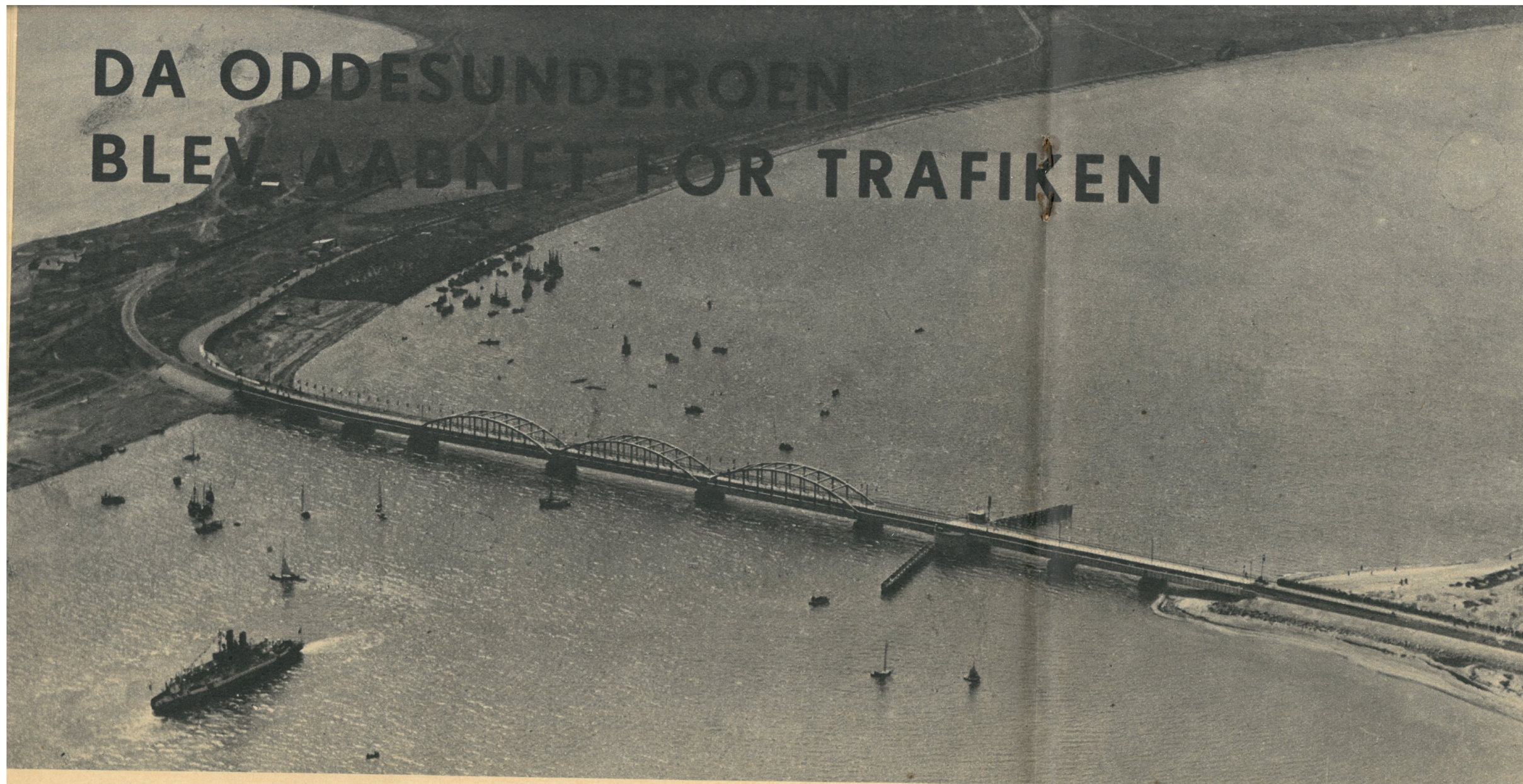
Udsigt over Broen, der forbinder Thy med det sydlige Vestjylland.
