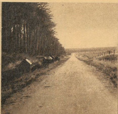
I Midten: Jordarbejdet paa den nye Maugstrupvej er færdigt, men Vejen venter paa at blive asfalteret.
